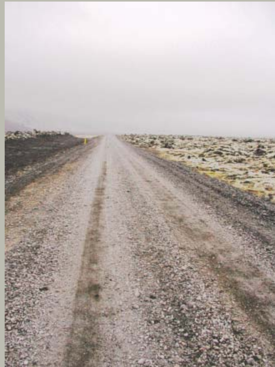
Mynd 118. Suðurstrandarvegur við Herdísarvík
